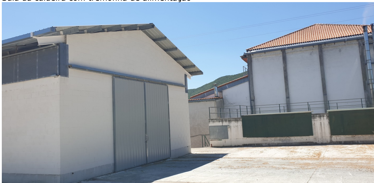
Visão geral. Em primeiro plano, armazém de estilha. À direita, acesso à tremonha de alimentação ao lado da sala da caldeira.
