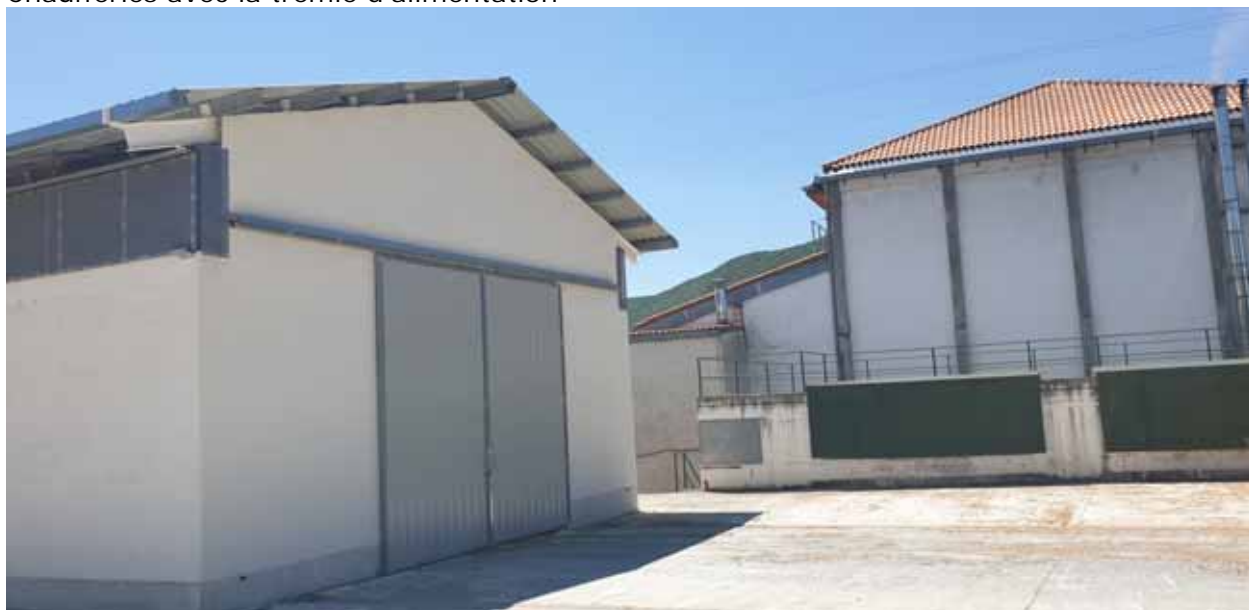
Vue générale. Au premier plan, remise à copeaux. A droite, accès à la trémie d'alimentation à côté de la chaudière.
