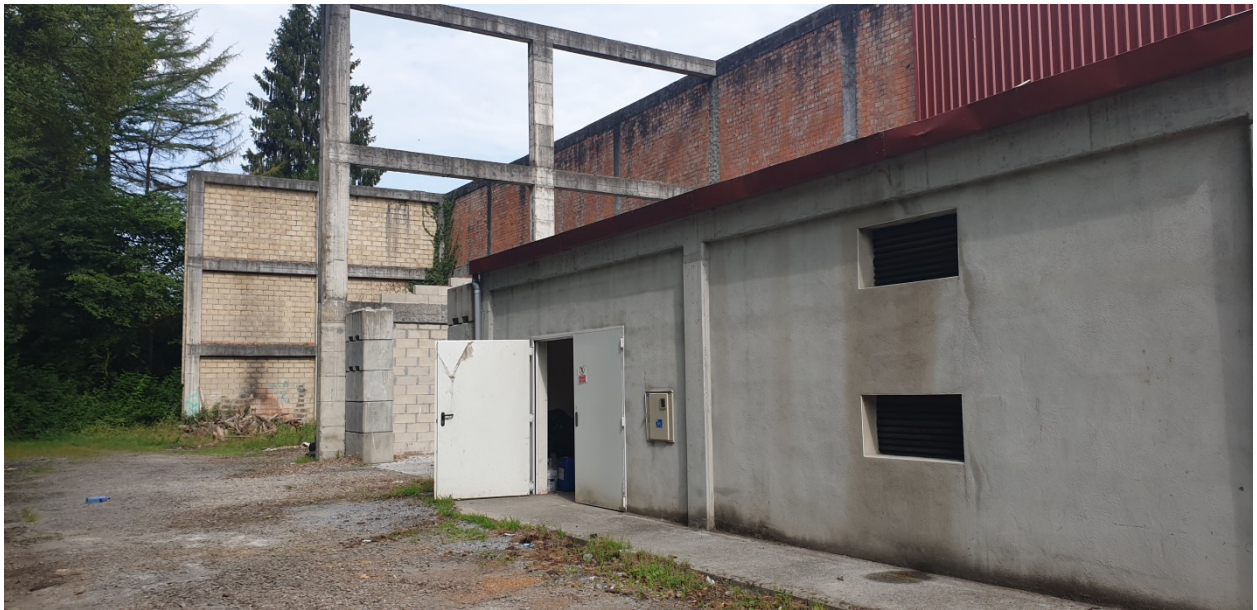
Instalações: sala de caldeiras e área de armazenamento
