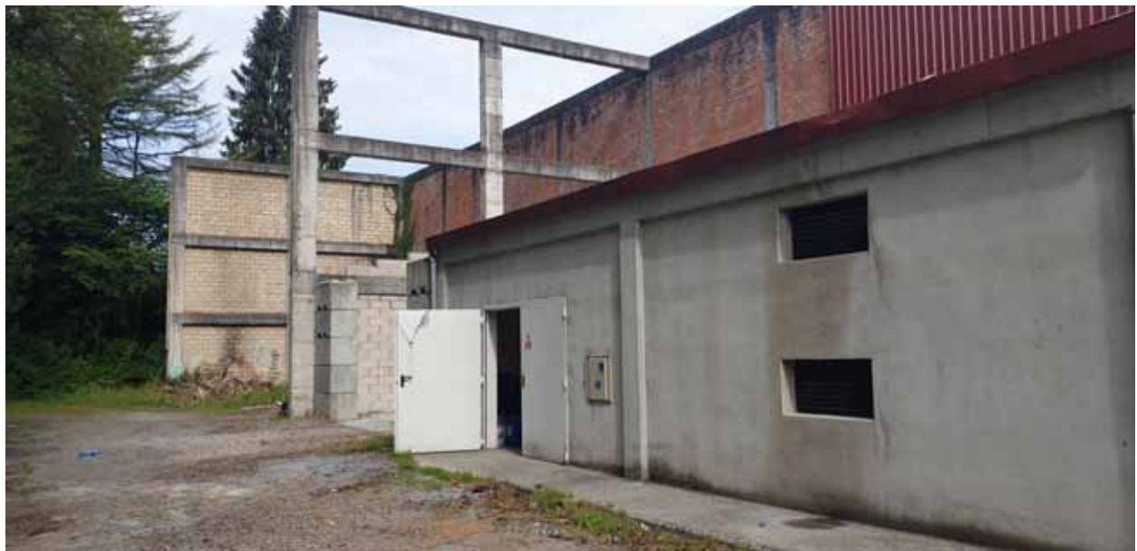
Instalaciones: sala de calderas y zona de almacenamiento
